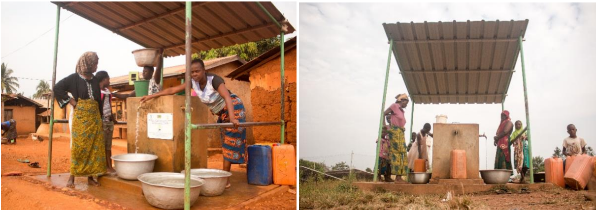
c) Borne fontaine d'adduction d'eau potable, source AT2ER
